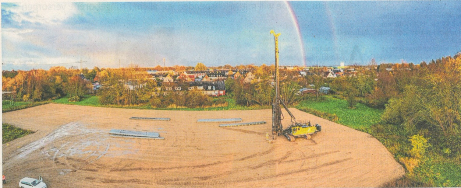
Über 1,5 Hektar erstreckt sich das Bauareal.
