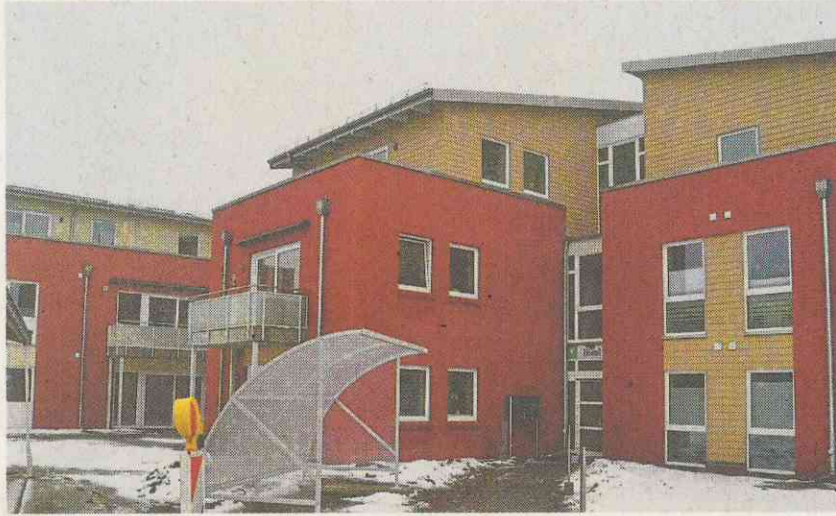
Die mit zwei Stockwerken und Staffelgeschoss versehenen Gebäude sind fertiggestellt. Nun wollen die Bewohner in Eigenregie die Außenanlagen gestalten.
